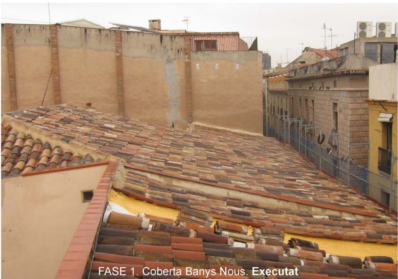
Coberta. Procés constructiu
